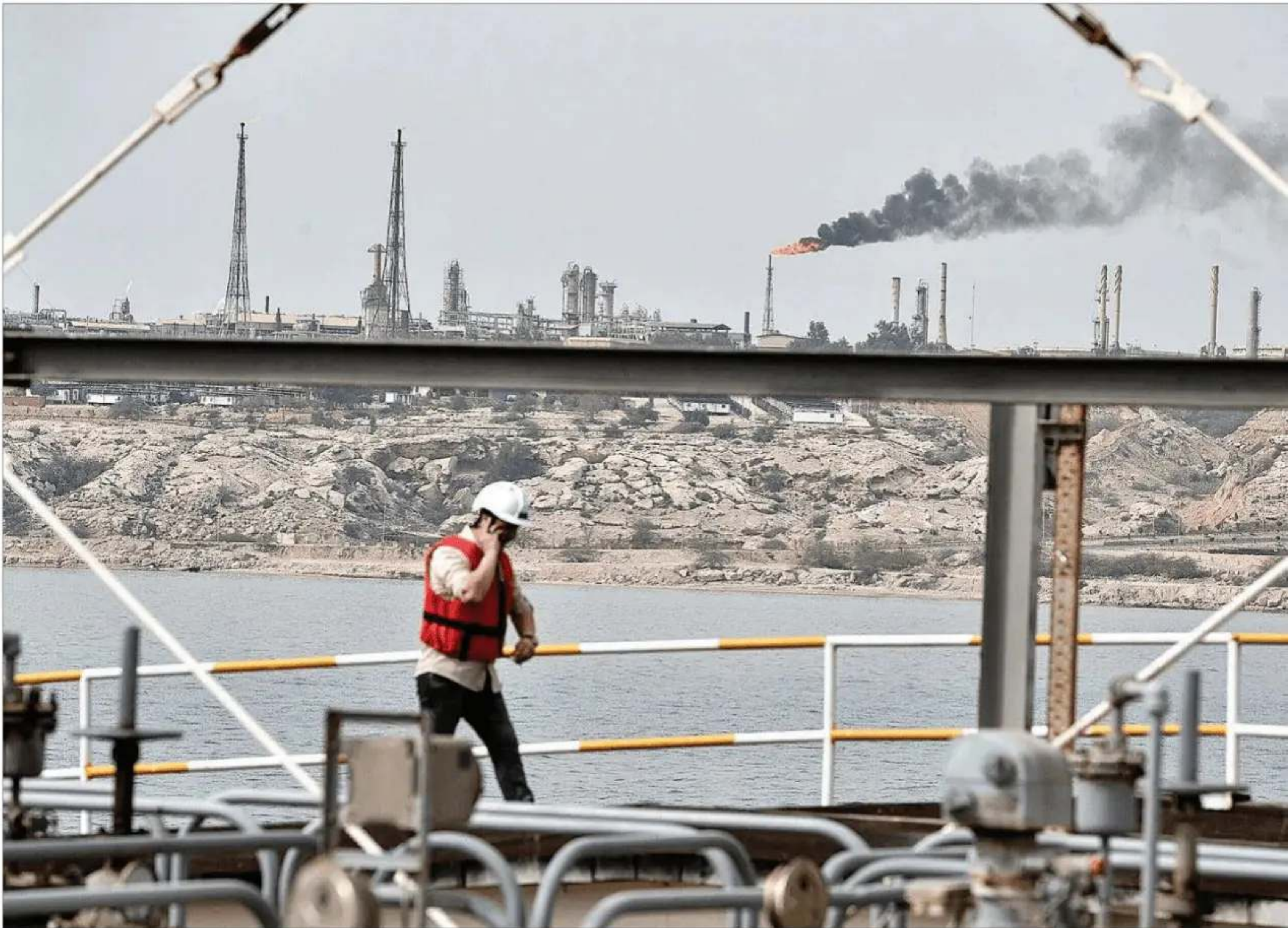
Vista general de la terminal petrolera del puerto de la isla de Jark, a 25 km de la costa iraní en el Golfo Pérsico y a 483 km al noroeste del Estrecho de Ormuz, en Irán, el 12 de marzo de 2017. GETTY
